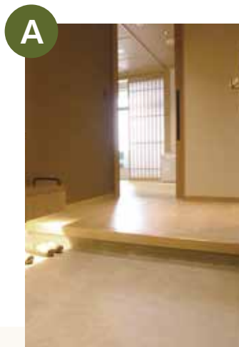
玄関入口: 段差 15cm
